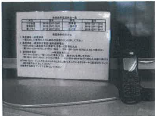
通信手段の確保 (衛生電話)
